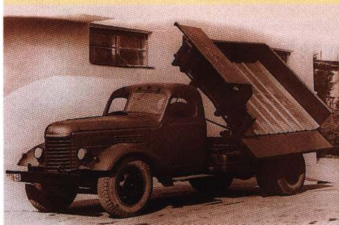
Трехсторонние автосамосвалы КАЗ-600 В оборудовались сварной платформой емкостью 2,4 м 3 и имели козырек для защиты кабины от падающего груза.
